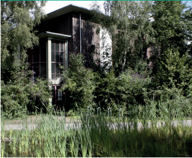
图 7: 莱茵内尔煤矿内由原配电房改建而成的城市森林站
